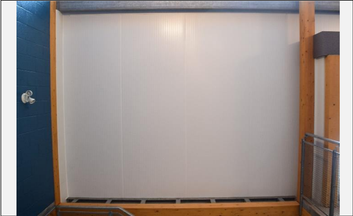
Espace n° 4 (1 er étage, escalier)
